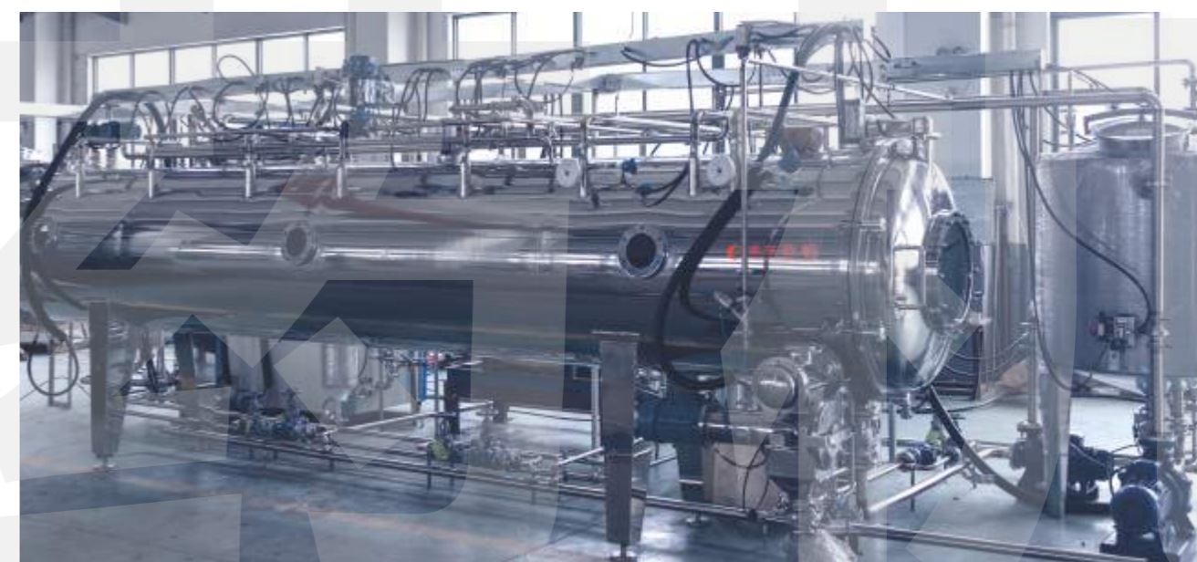
上海成东科技带式干燥生产车间 Chengdong production workshop
